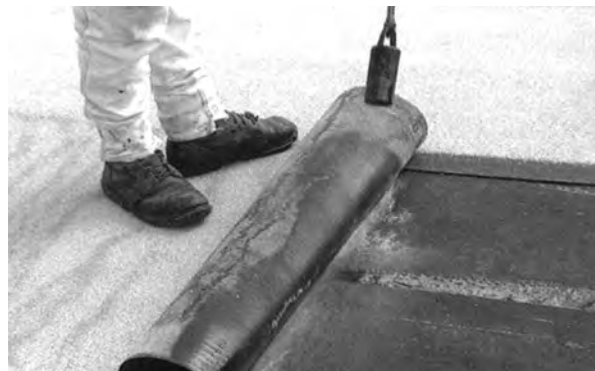
Foto 2: Un trabajador del techado está empujando un rollo de membrana.
