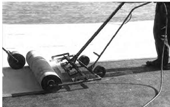
Foto 3: Un trabajador del techado empuja la carretilla de soplete de espaldas.
