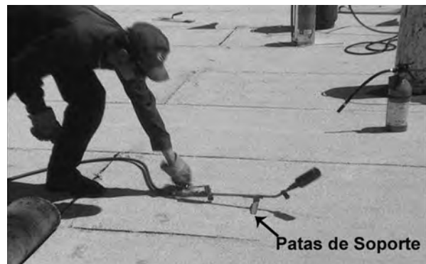
Foto 1: Siempre establezca el soplete de mano en su soporte.
